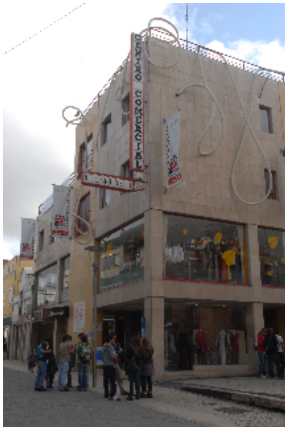
FOTO 3 – ARTZ III, INSTALAÇÃO NO EXTERIOR DO EDIFÍCIO DO THE ENGLISH CENTRE
